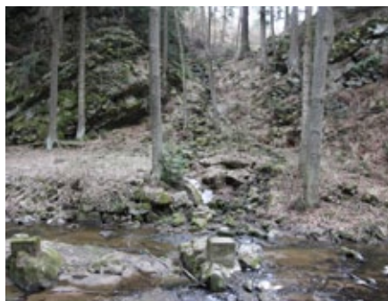
Obr. 6/ Kamenné násypy pro úzkokolejku a betonové pilíře bývalého mostu
